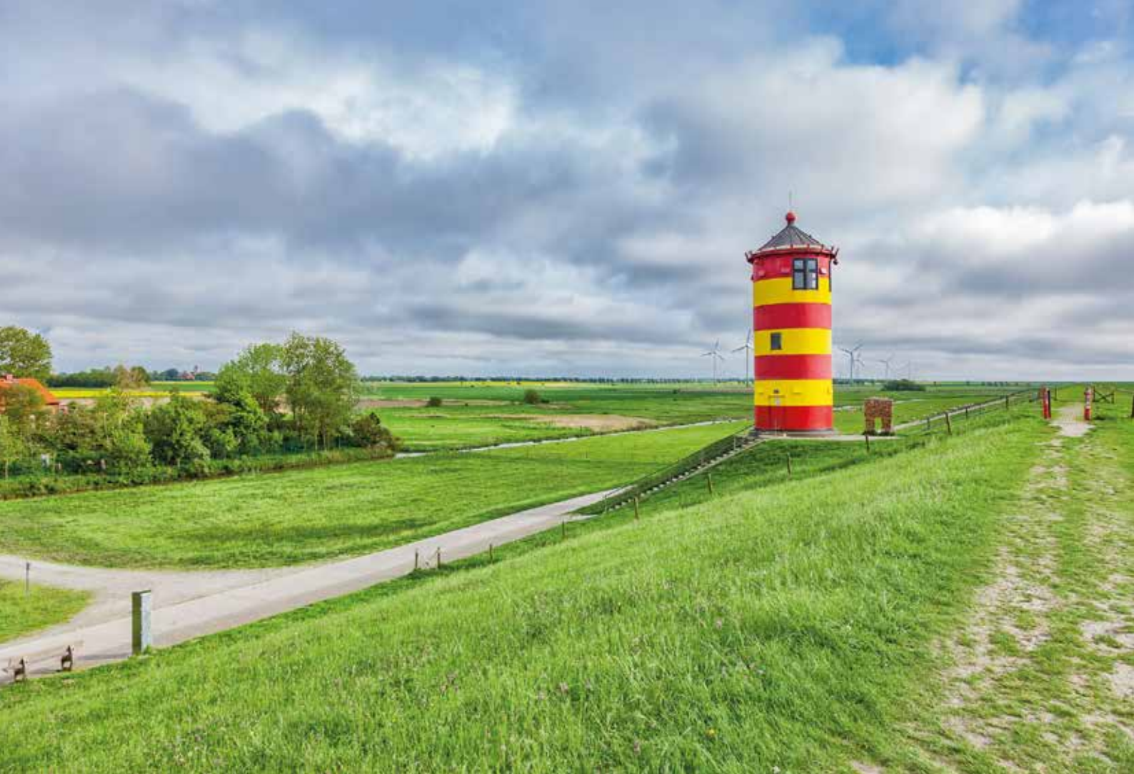
▲ Leuchttürme, Wahrzeichen der Küste in Niedersachsen (Leuchtturm Pilsum)
